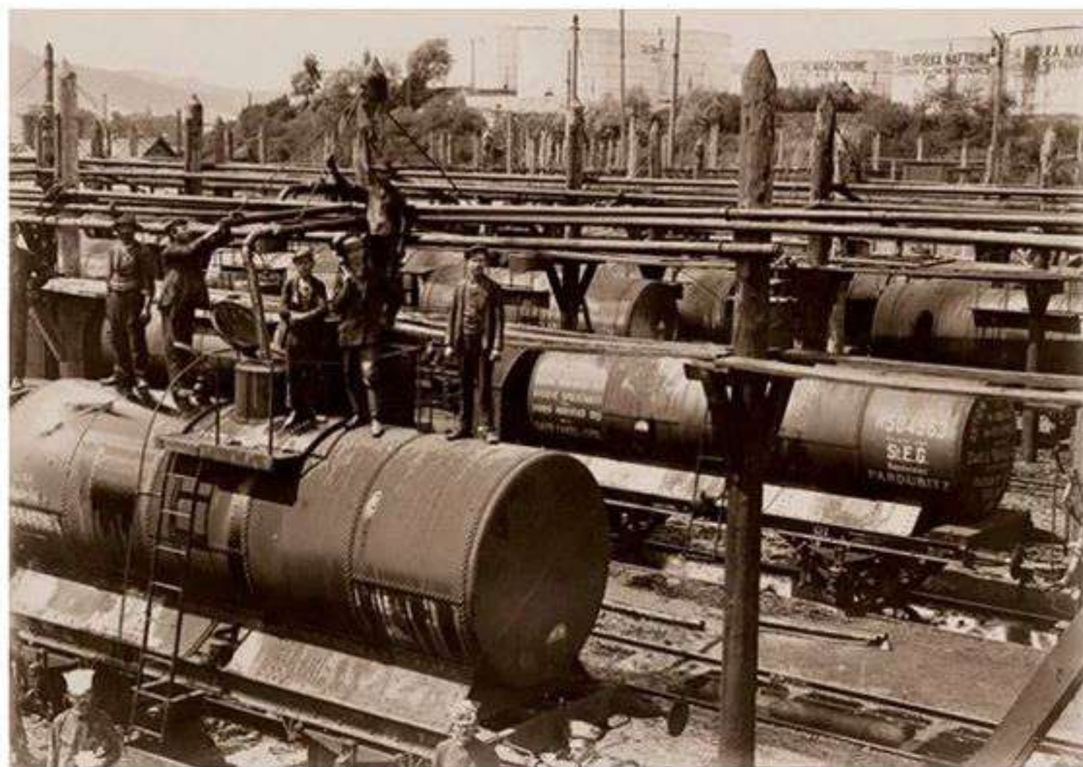
Залізнична станція в Бориславі була побудована в 1872 році. На фото процес завантаження цистерни нафтою, 1910 рік
