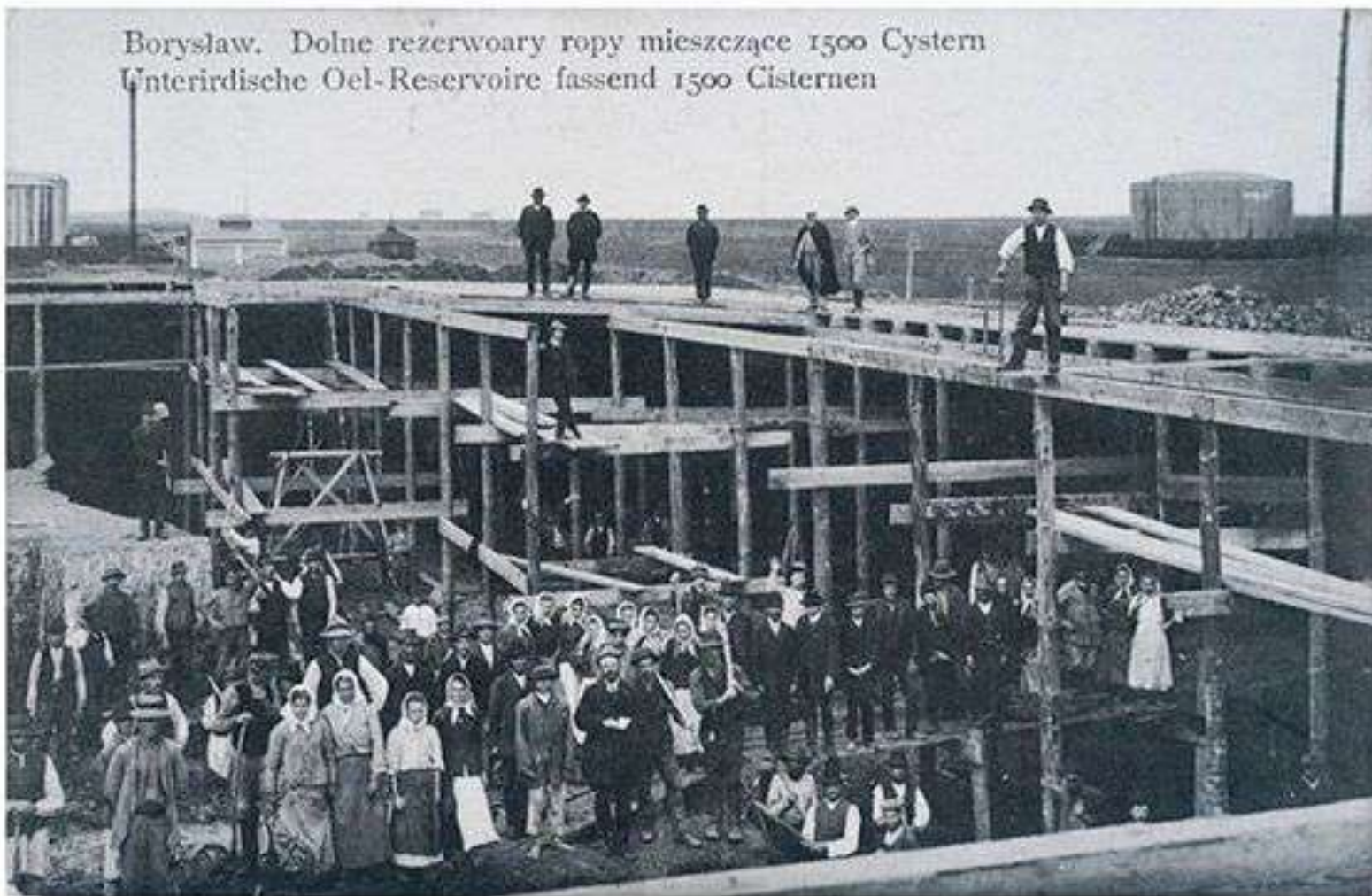
Борислав. Будівництво нафтових резервуарів. Поштівка 1909 року
