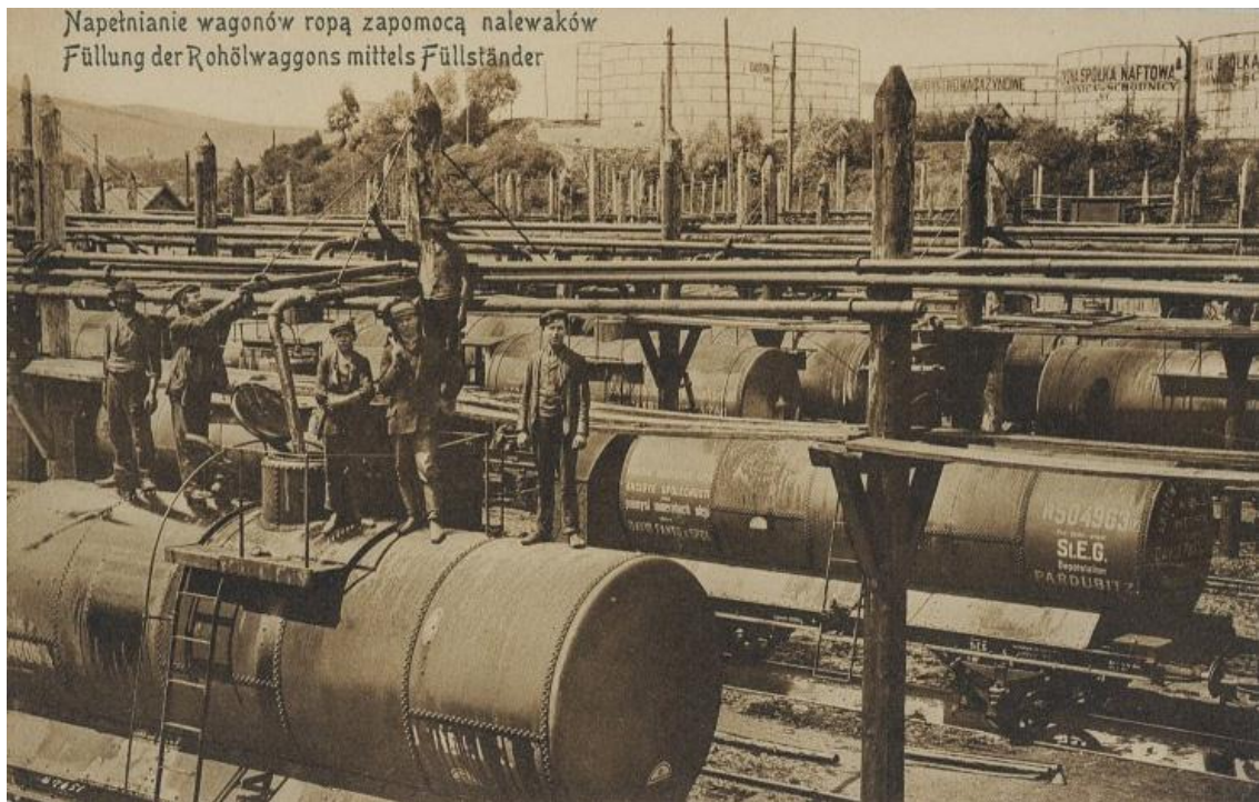
Зона наповнення залізничних цистерн нафтою на станції Борислав (1910 р.)
