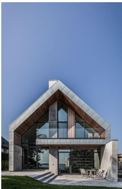
Рис.1.4. Зовнішній вигляд будинку [5].
