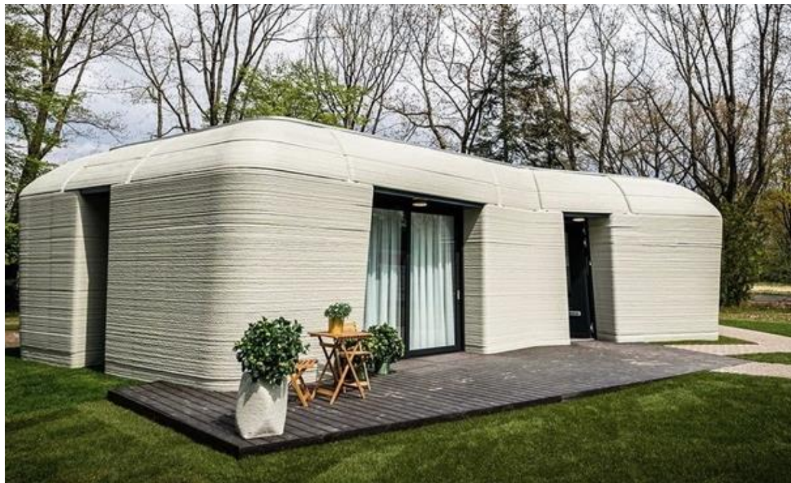
Рисунок 1.14 – Будинок, збудований за технологією 3D друку
