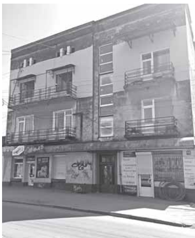
Імовірно, сучасний вигляд приміщення колишнього кріпо
